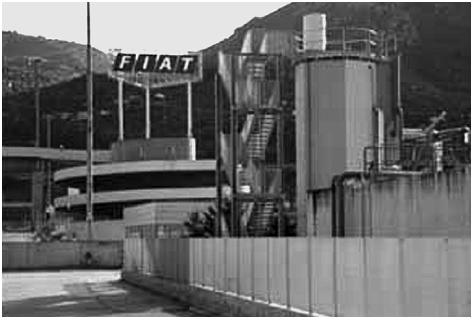
Fig. 2 - Particolare dello stabilimento FIAT di Termini Imerese.
