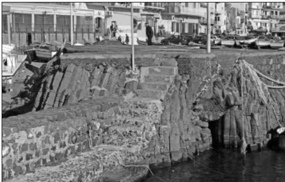
Fig. 33 - Basalti colonnari a canna d'organo ricoperti dal cemento all'interno del molo vecchio di Acitrezza.
