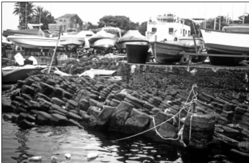
Fig. 30 - Basalti colonnari ricoperti dal cemento dopo i lavori di ampliamento del porto negli anni '80.
